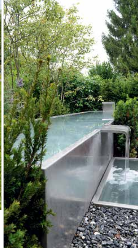
Chromstahlbecken mit zweistufigem Wassereinlauf.
